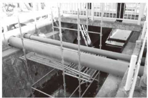
平行に架設されたφ400とφ200の水管 橋に施工
